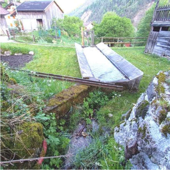
La vasca riceve un apporto idrico a getto continuo da una sorgente sotterranea, convogliato direttamente mediante una condotta posta all'estremità di testa dello specchio d'acqua principale..
