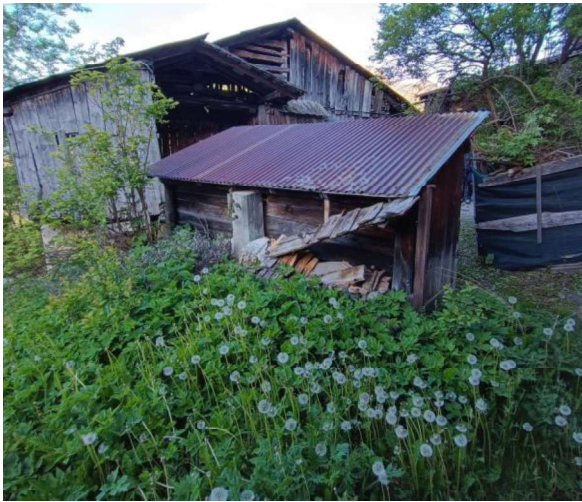
Il retro; qui è possibile vedere il fuso che alimenta la vasca, nascosto dal tavolato ligneo, che non si percepisce dal fronte.
